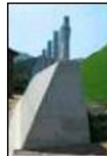
土石流入防止壁
